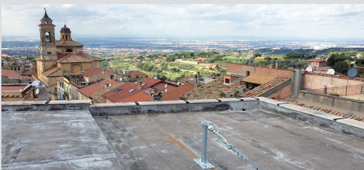
Installazioni di linee vita Combo
