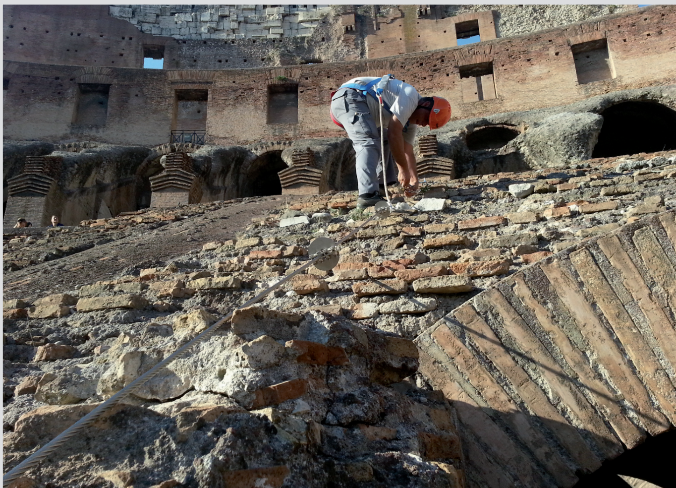
Fasi di installazione su Colosseo (Roma)
