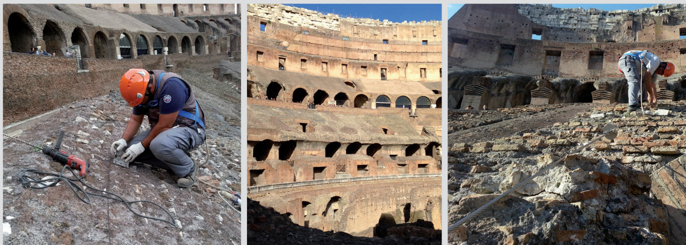
Fasi di installazione su Colosseo (Roma)
