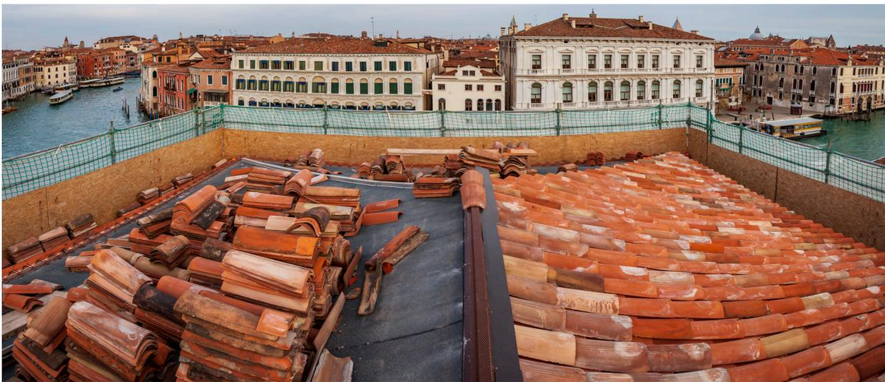
venti che hanno interessato la struttura secondaria del tetto, realizzarti nella seconda metà del '900. In generale l'intervento previsto è di tipo conservativo, volto dunque al mantenimento degli elementi costitutivi la copertura, migliorando laddove necessario, le loro prestazioni meccaniche e di durata nel tempo.
