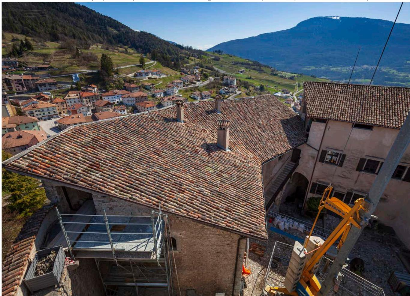
Si è deciso così di intervenire su queste due coperture analizzando le condizioni di partenza delle stesse e optando in entrambi i casi per il rifacimento dell'intero pacchetto di copertura, con l'aggiunta, solo in una delle due situazioni, di un consolidamento strutturale.
