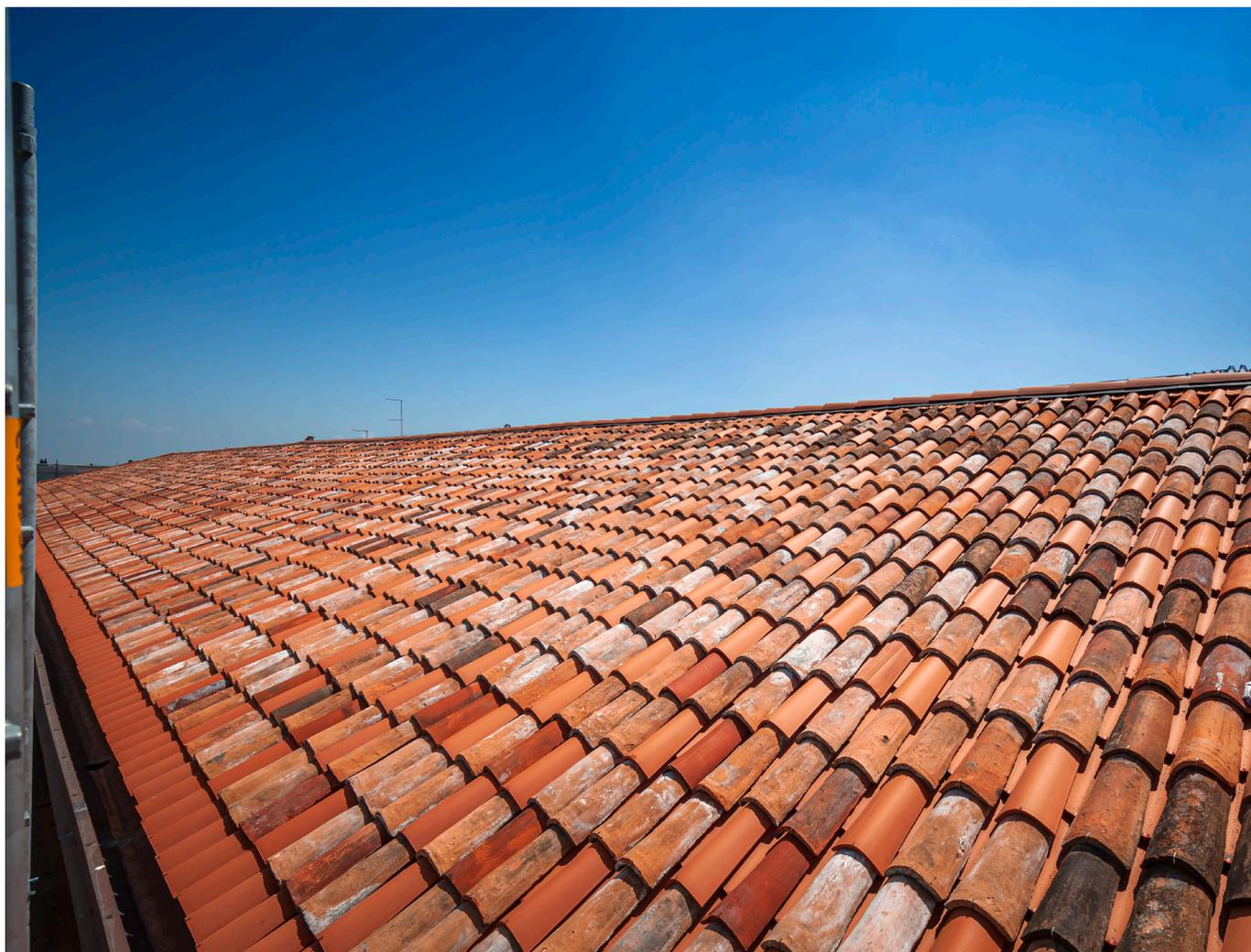
Una volta posato il sistema la copertura è stata completata con un manto di coppi, in parte recuperati attraverso una cernita attenta di quelli esistenti ed in buone condizioni, che sono stati opportunamente dimensionati, in parte nuovi, che oggi riconsegnano all’ospedale e ai suoi pazienti, una copertura perfettamente efficiente in grado di assicurare sicurezza e comfort a tutti gli ambienti sottostanti.
