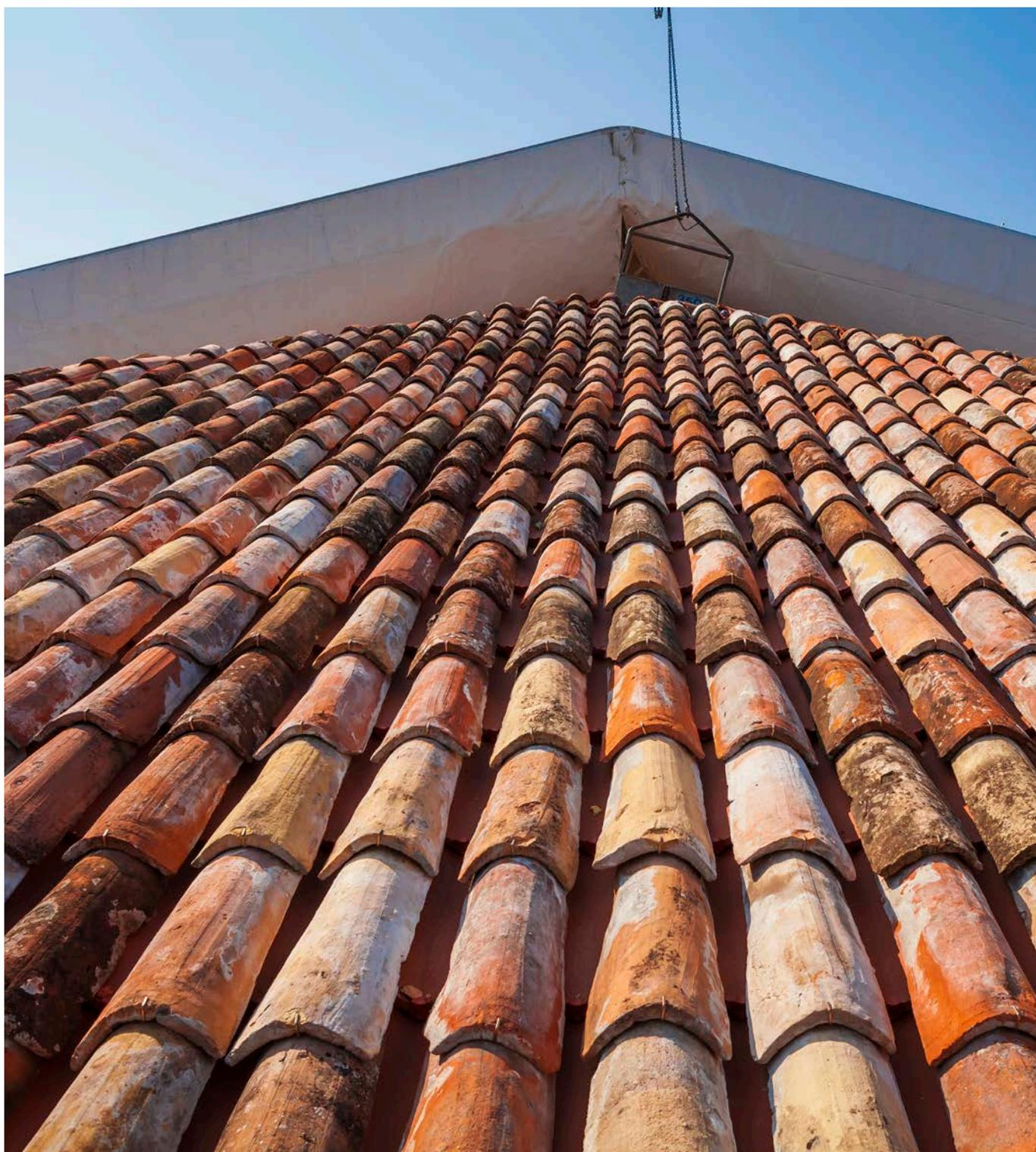
Sopra il sistema **AERcoppo®** è stato poi posato il manto di copertura, recuperando in parte i coppi esistenti (coppi di coperta) ed integrandoli con elementi nuovi (coppi canale), così da ottenere una perfetta resistenza ed una gradevolezza estetica che non si discosta dal manufatto originale. Senza dimenticare poi l'installazione di una linea vita per accrescere la sicurezza degli operatori.
