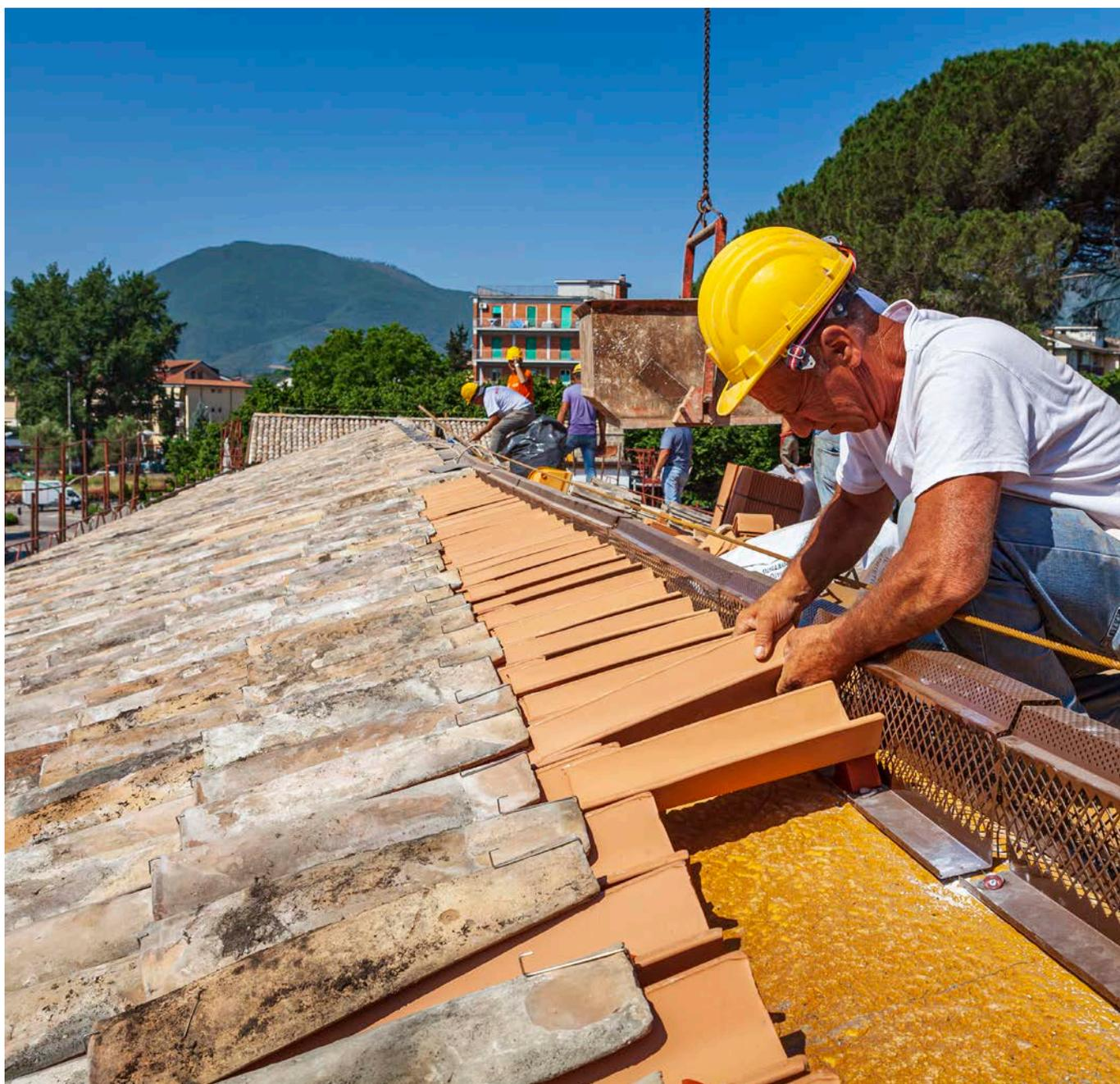
La copertura è stata ovviamente uno dei passaggi più importanti del progetto. Andava interamente ricostruita. Si è optato per una capriata classica in legno lamellare che poggia direttamente sui muri portanti tramite la realizzazione di un cordolo perimetrale mentre sulle facciate di testa è stato ricostruito il tessuto murario per completare la geometria della campata.
